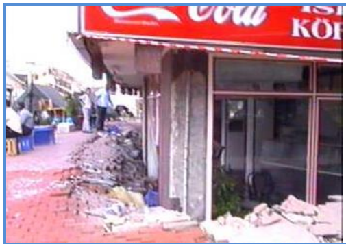
图 15 地基塌陷引起房屋破坏
