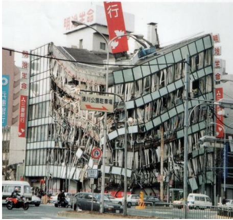
图 13 框架-抗震墙房屋破坏
