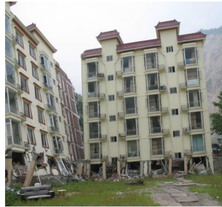
图 14 底层框架砖房破坏
