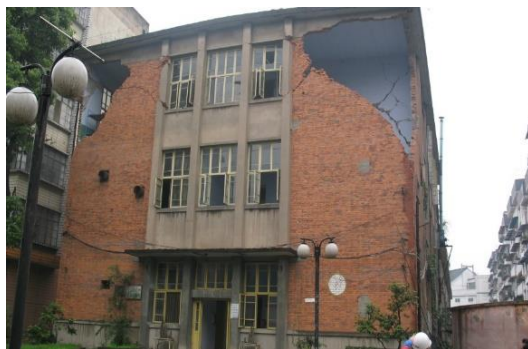
图 12 砌体结构房屋破坏
