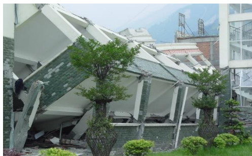
图 11 钢筋混凝土框架房屋破坏
