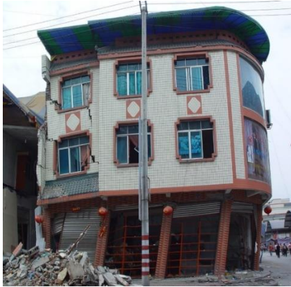
图 14 底层框架砖房破坏
